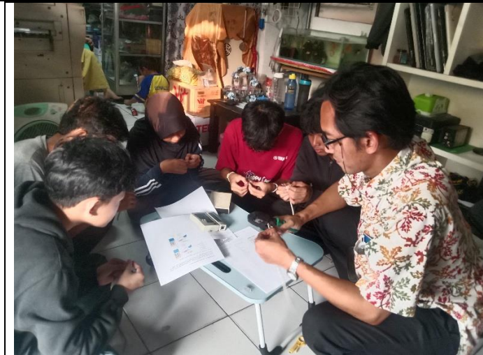
Sumber: Dokumentasi PKM (2023) Gambar 4. Pemotongan kabel UTP
